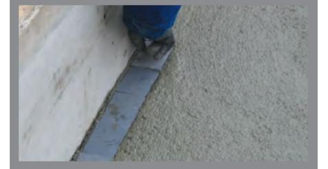
チタンガードは防護コンクリートの両端に敷設
